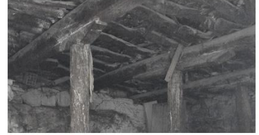
Στατικά στοιχεία που χωρίζουν το κτίσμα σε επιμέρους τμήματα.
