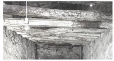
Δέσμες οροφής, με συνήθως ακατέργαστα τα φυσικά υλικά. Για την δημιουργία υπερυψωμένου επιπέδου σε όροφο, μετά τον πυλώ τοποθετούνταν πύλινα πλακάκια ή πλάκες από γυψομάραρο.
